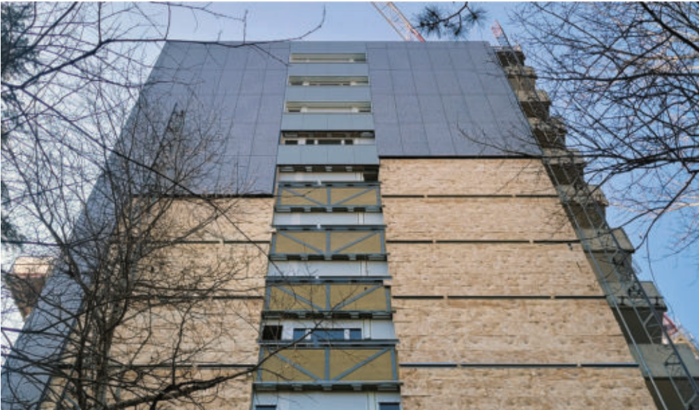
Cantiere Torre 10, 2023 - Ph: Campomarzio
