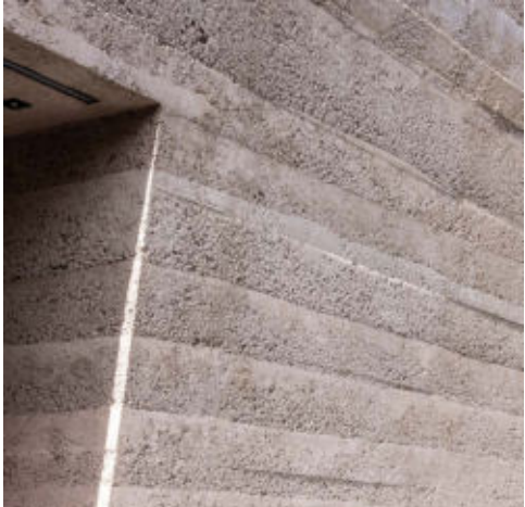
Schicht für Schicht: die Stampfbetonmauer wurde händisch gestampft. Ziel: unterschiedlich breite Schichten - organisches Erscheinungsbild.
