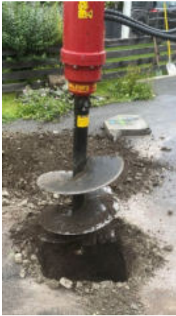
Bohrung für Pfahlgründung, ersten Balkenlage fixiert die Position der Stützenköpfe
