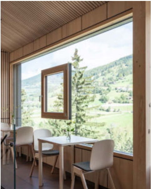
Fensterfront Fassade Ost
