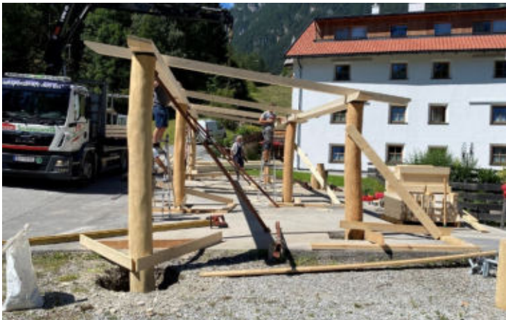
Bohrung für Pfahlgründung, ersten Balkenlage fixiert die Position der Stützenköpfe
