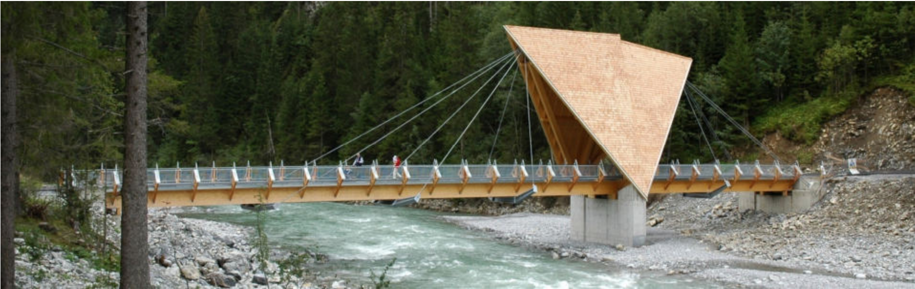
Einhüftige Schrägseilbrücke über den Lech mit einer Hauptspannweite von 24 m, die Verankerung der Schrägseile ist eine überdachte V-Stütze
