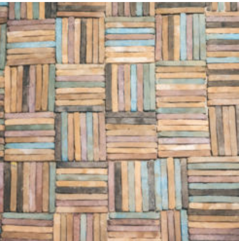
Terracotta Bleistift ca. 14.000 Stück selbst verlegt.
