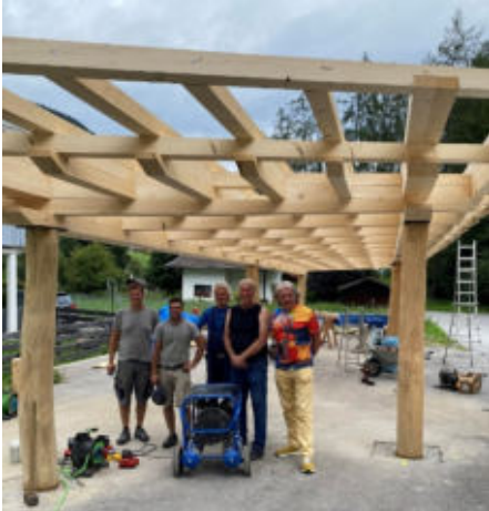
Montage der letzten Balkenlage
