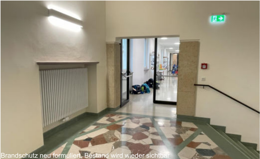
Brandschutz neu formuliert, Bestand wird wieder sichtbar
