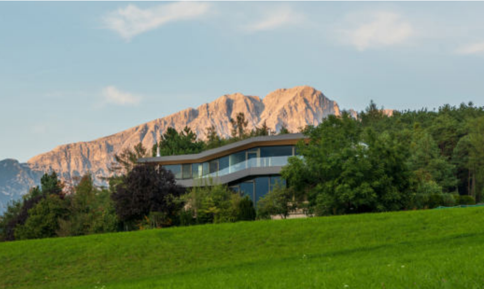
Situation nach durchgeführten Maßnahme
