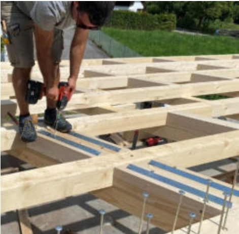
Befestigung der neuen Schubverbinder
