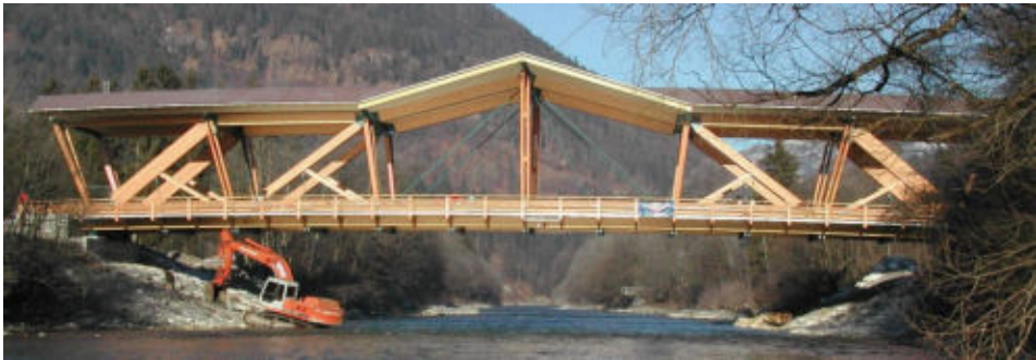
Oberes Bild: Staffenbrücke in Kössen, Schwerverkehrsbrücke mit einer Spannweite von über 50 m, 2004
