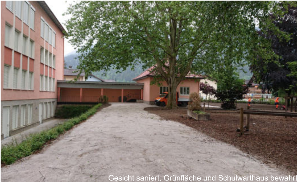
Gesicht saniert, Grünfläche und Schulwarthaus bewahrt
