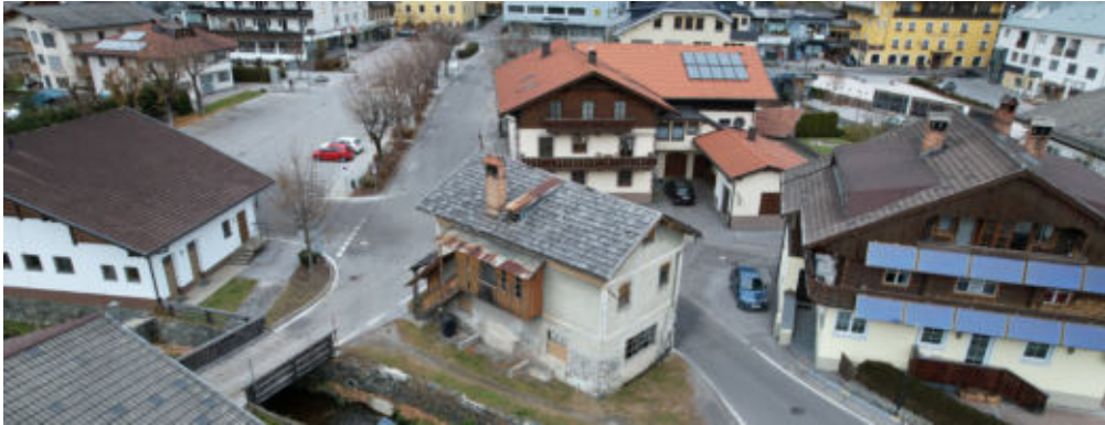
Schmiede als neuralgischer Punkt im Ortszentrum – Bild vor Umbau
