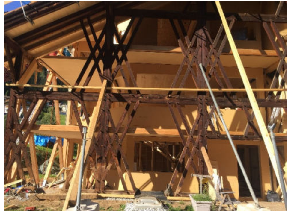
Einbau der „Haus in Haus“ Konstruktion im Bereich der ehemaligen Scheune
