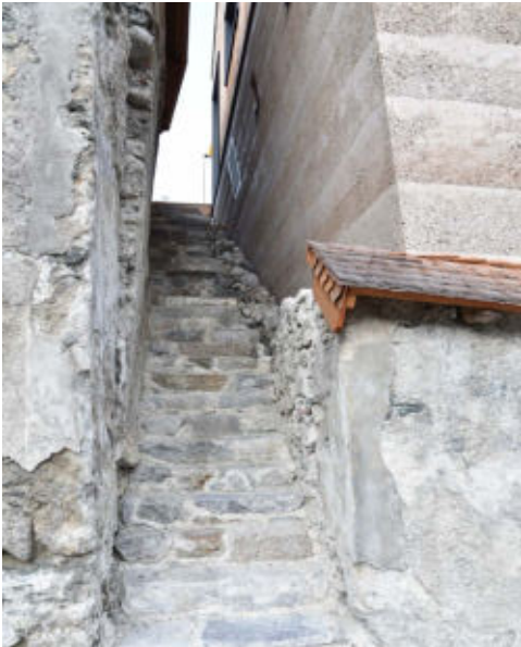
Schnittstelle Bestand und Neubau: Stein / Stampfbeton / Holz
