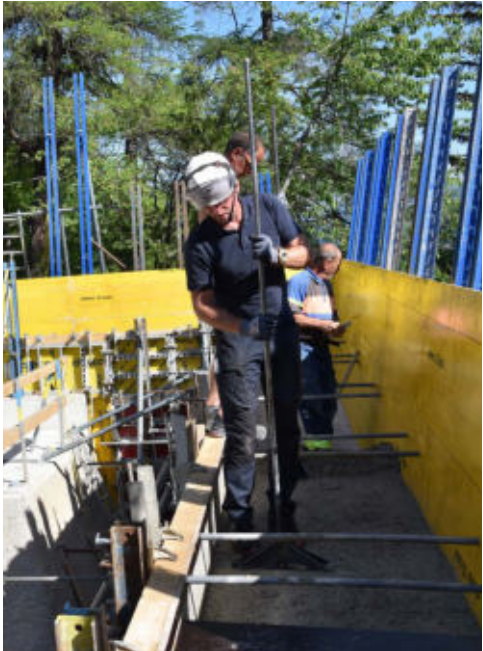
Schicht für Schicht: die Stampfbetonmauer wurde händisch gestampft. Ziel: unterschiedlich breite Schichten - organisches Erscheinungsbild.
