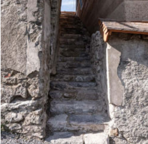
Die im Krieg zerstörte Treppe wurde von Restauratoren mit freigelegten Steinen rekonstruiert.
