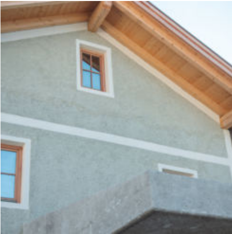
Materialübergang/Anschluss Bestand/ Zubau.
