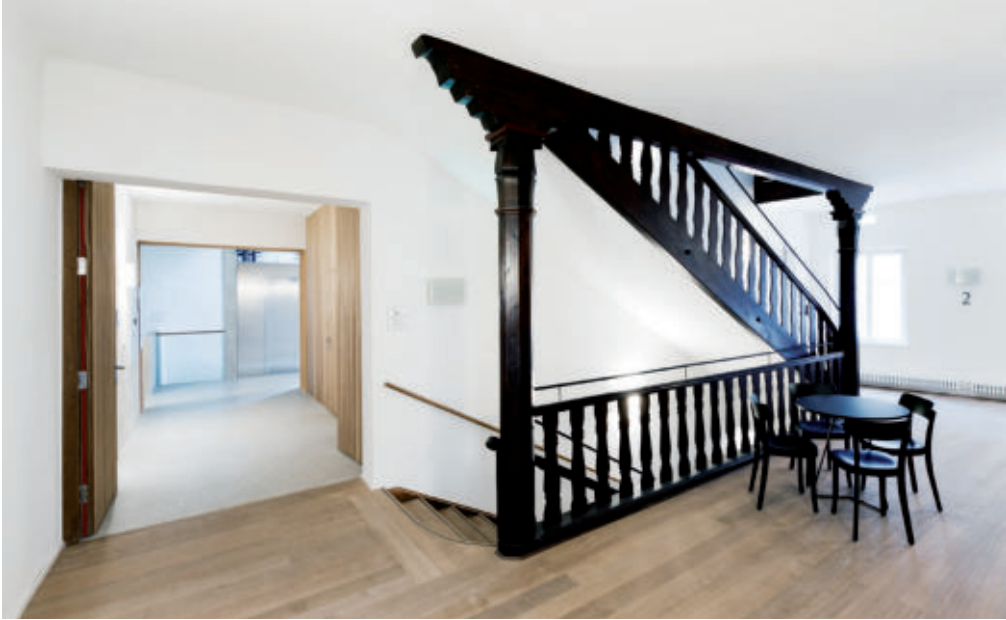
Erhalt und Restaurierung der alten Stiege aus 1927, baupolizeiliche Ertüchtigung, Abstimmung mit Mobiliar, Entwurf aus ähnlicher Entstehungszeit
