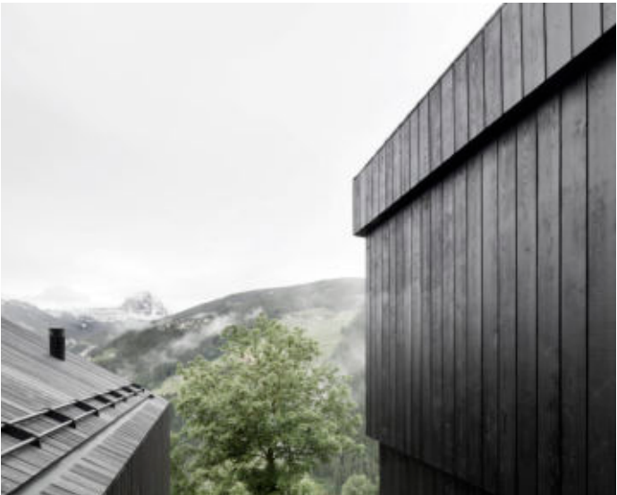
Wie einst: Der First ins Tal, Fassadenvorsprünge für den Holzschutz, Beständigkeit. Konstruktiver Holzschutz gibt der Fassade ihre Gestalt.
