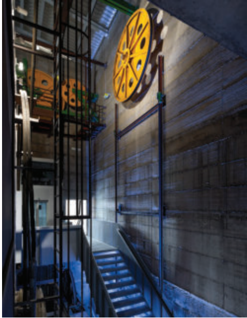
Endstand: Detail vertikaler Erschließungsraum
