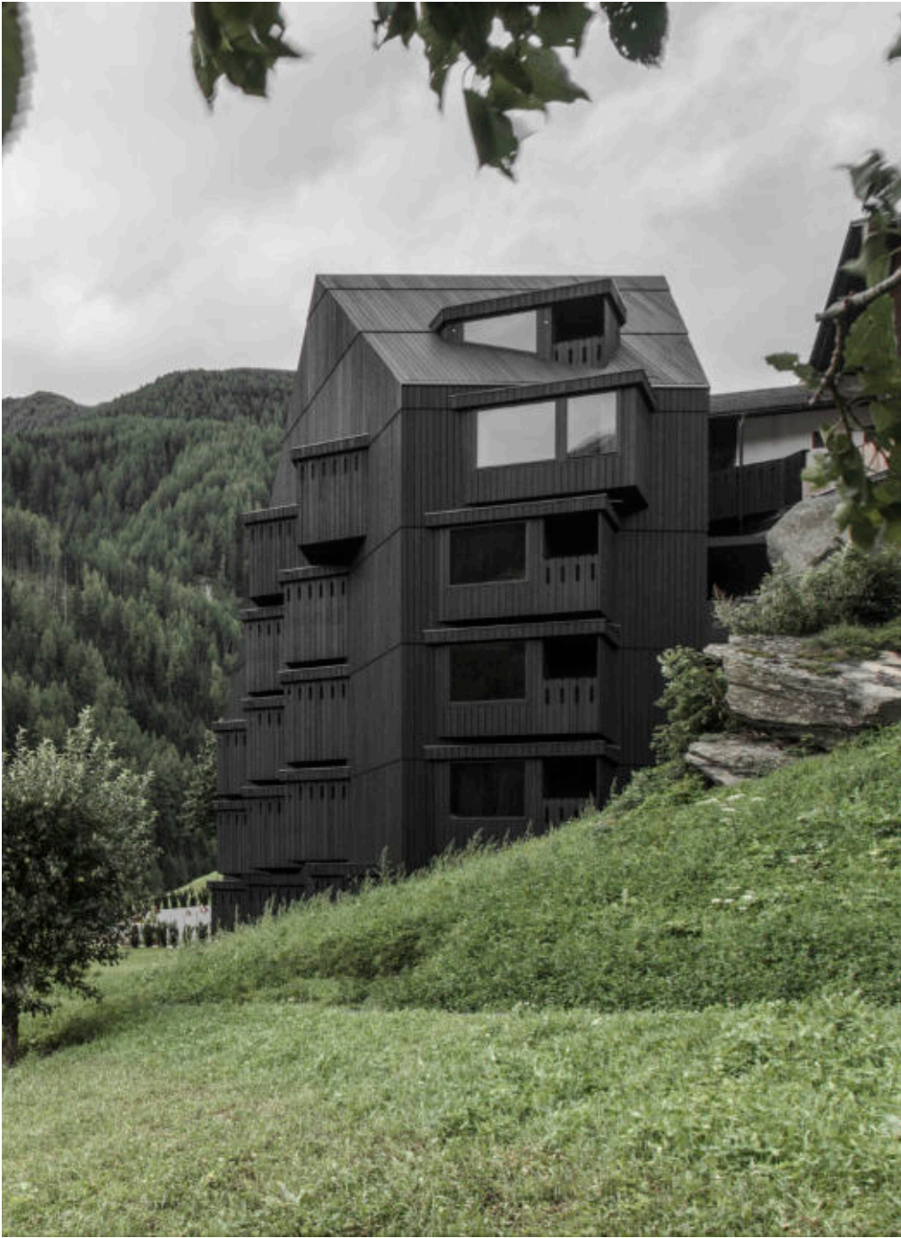
Klimagerechtes Bauen: Die Nordfassade wird klein gehalten, die Erker sind witterungsgeschützte Aussichtspunkte.
