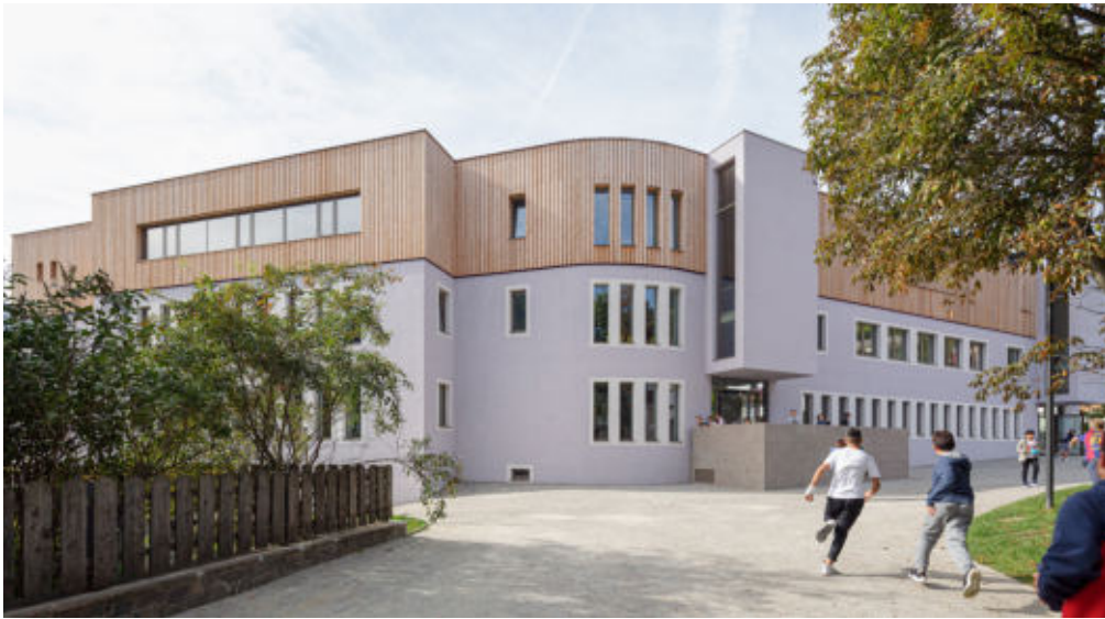
Sanierung und Erweiterung
