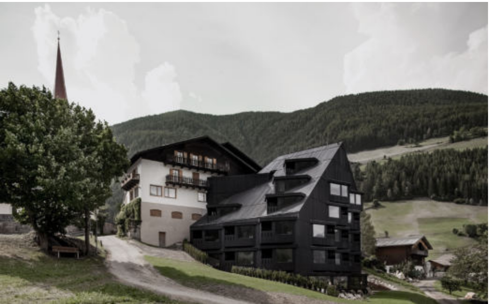
Weiterbauen im Bestand und in der Umgebung: Tiefgezogene Traufe und maximale Fläche nach Süden.
