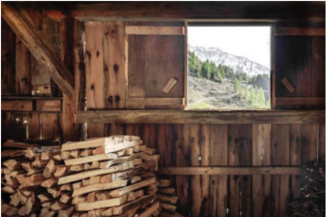
Bestehender Stadel mit Lichtöffnung und Schiebeläden
