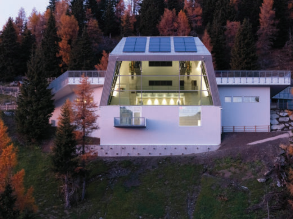
Endstand: Südansicht mit Detail der neuen Photovoltaikanlage
