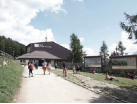
Bestand: Ansicht West
