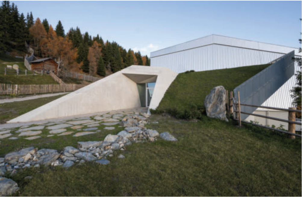
Endstand: Ansicht West
