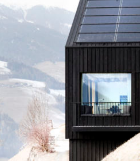
Autarkie: Energie aus PV und Erdwärme...
