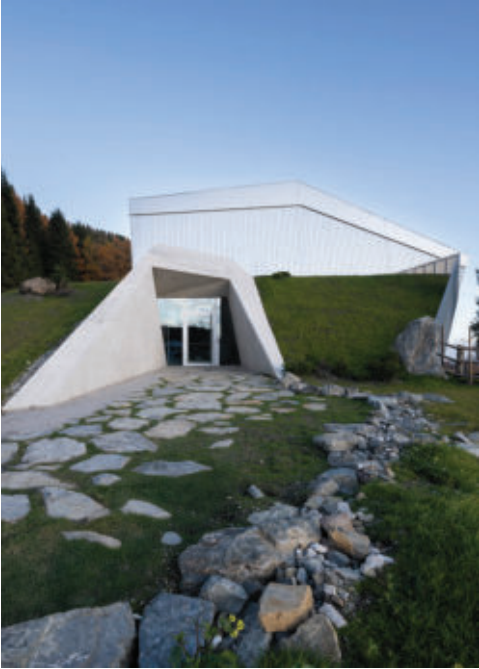
Endstand: Ansicht West
