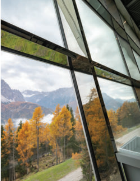
Endstand: Detail Glasfassade
