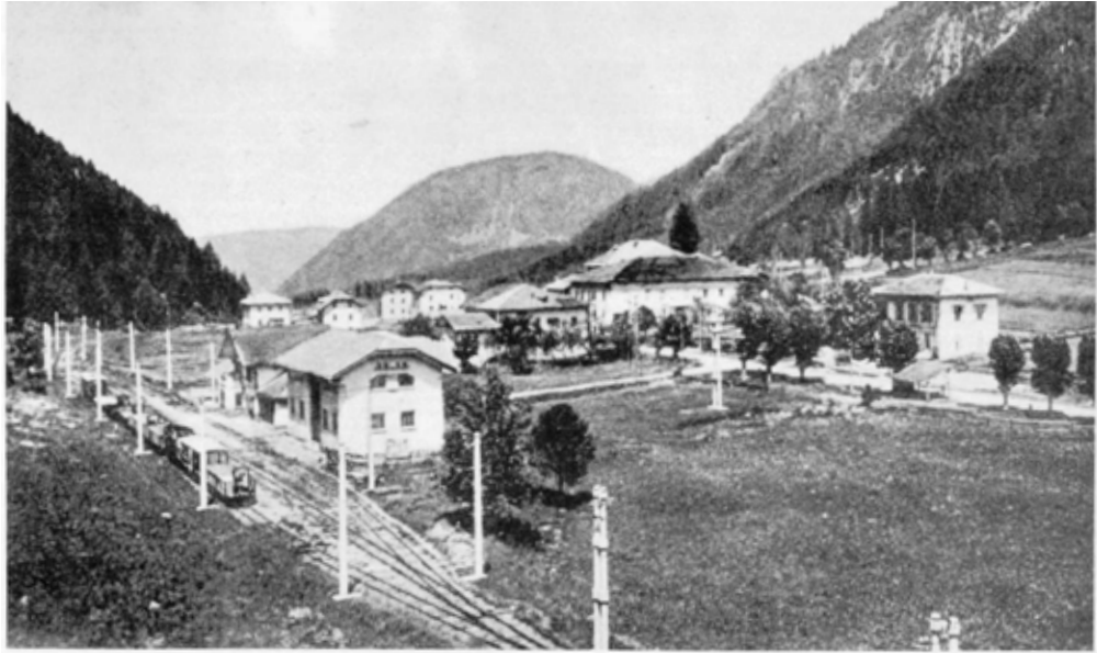
La stazione di S. Lugano con la sottostazione elettrica. (Da cartolina, collez. Costa).
