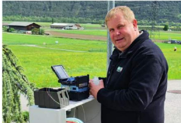
GemeindeWerke-Bereichsleiter Klaus Kluckner beim Zusammenschluss der Glasfaser-Direktverbindung nach Flaurling.
